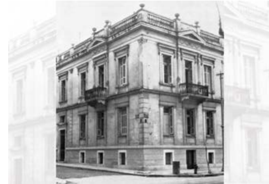
24. Άποψη κτηρίου ΧΥΣ 1916, επί της οδού Αχαρνών κοντά στη Πλατεία Βάθης (Φωτογραφικό αρχείο ΓΥΣ)
